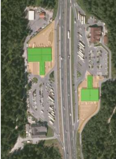
Slika 4: Primer bencinskega servisa kot dela počivališča na avtocesti, katerega del so tudi parkirne površine in samostojen gostinski objekt
